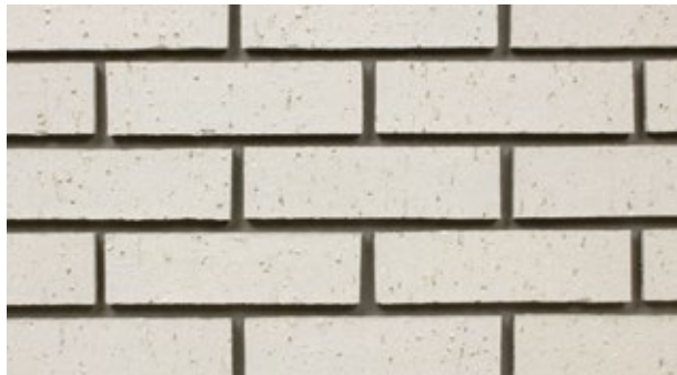
目地詰め施工前
