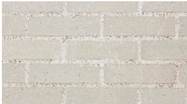
目地詰め施工イメージ
