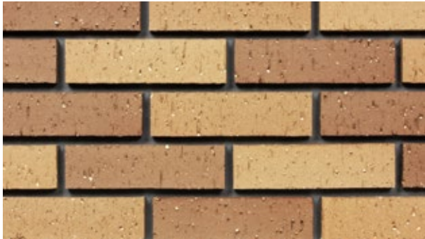
目地詰め施工前
